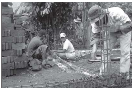
Gambar 4.7 Buruh bekerja di proyek bangunan.
