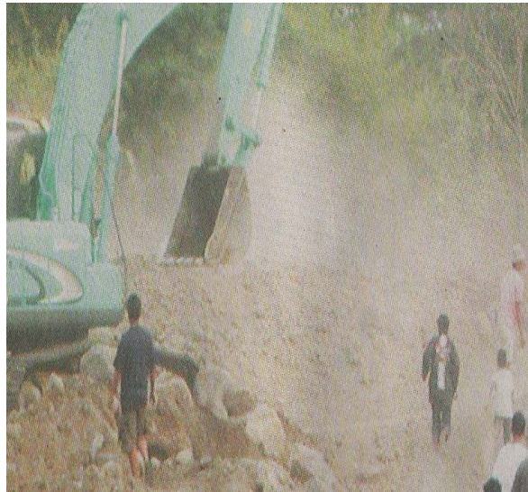
Gambar 3.10 : Tanah Longsor Akibat Ulah Manusia
