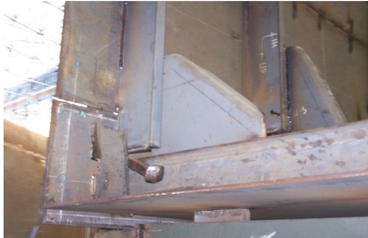
Gambar 19.10 Pemasangan bracket
