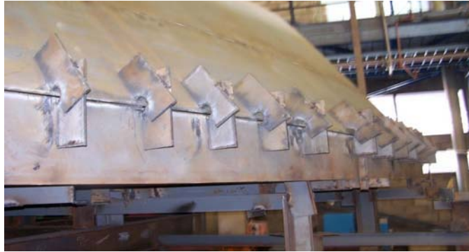
Gambar 19.8 Pemasangan stopper sambungan miring
