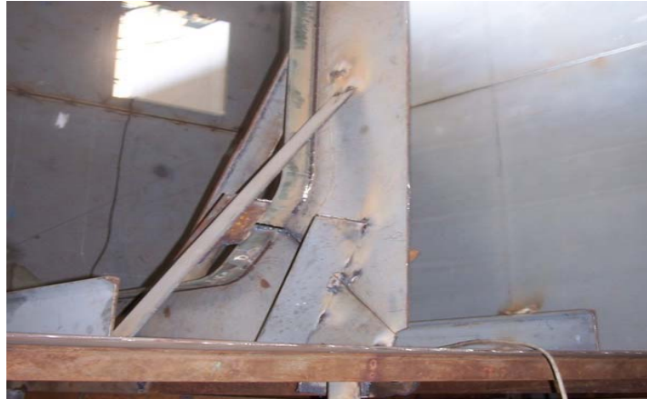
Gambar 19.7 Pemasangan web
