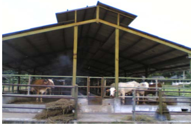
Gambar 73. Kandang Sapi yang Pembatasnya Terbuat dari Pipa-pipa Besi
