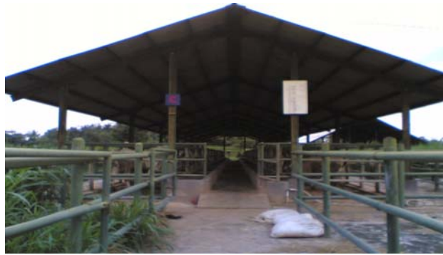
Gambar 72. Kandang Sapi yang Pembatasnya Terbuat dari Pipa-pipa Besi
