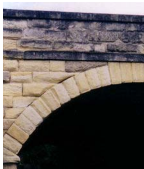
Gambar 20.35. Jembatan di Oamaru-Otago-New Zealand dibangun dari batu kapur
