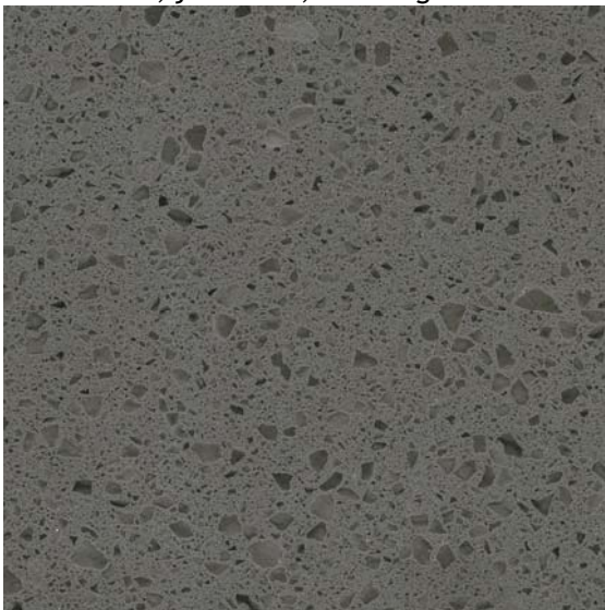
Gambar 20.77 Permukaan semen yang diaplikasikan pada bangunan
