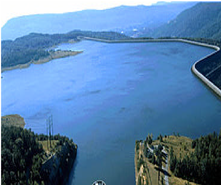
Gambar 20.1 Waduk sebagai sumber energi potensial air
