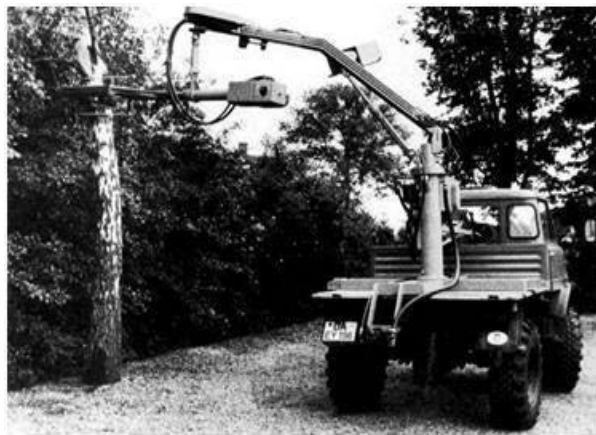
Gambar 11. Teknik Penggoyangan Pohon Induk Benih secara Mekanis(Ari Hidayanto, 2010)
