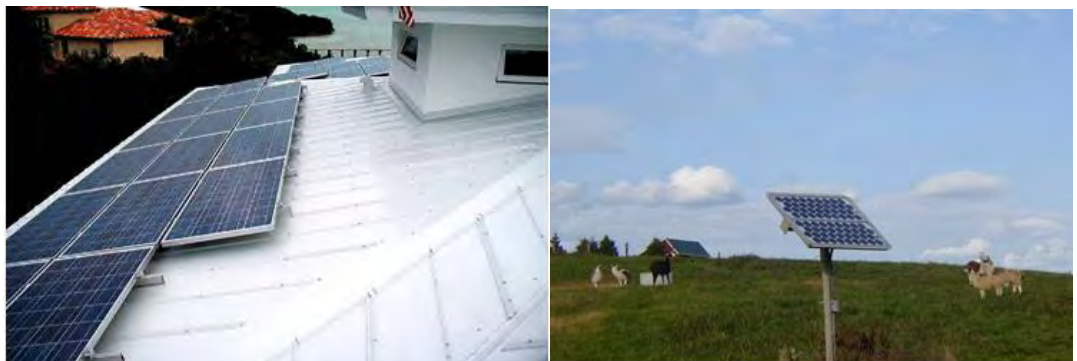
Pemasangan Panel Solar di atap rumah dan di perbukitan
