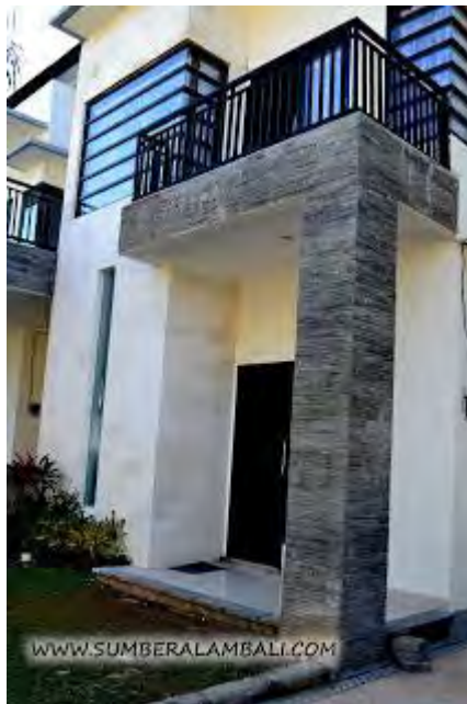
Aplikasi pemasangan batu alam untuk tiang rumah
