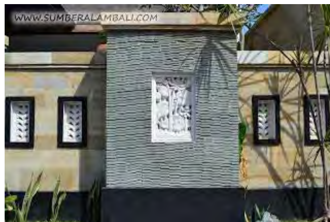
Aplikasi batu alam alur bali green dengan palimanan untuk dinding pagar depan rumah
