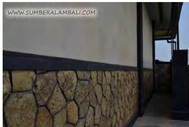
Aplikasi pemasangan batu alam emping
