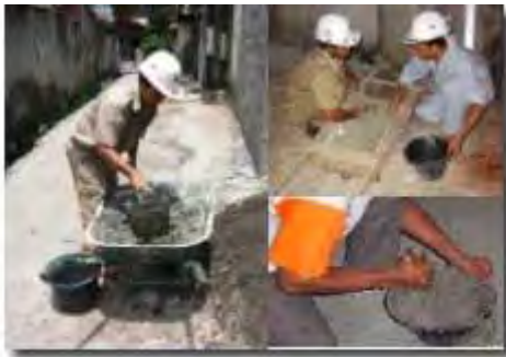
Pencampuran dengan tangan (manual)
