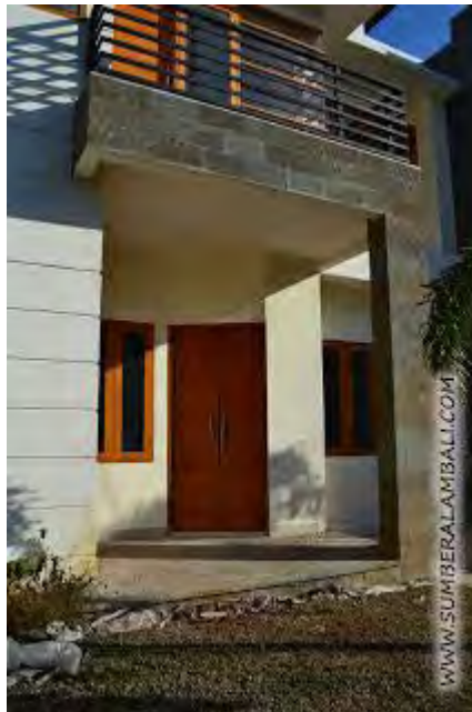
Aplikasi pemasangan batu alur pada pilar rumah
