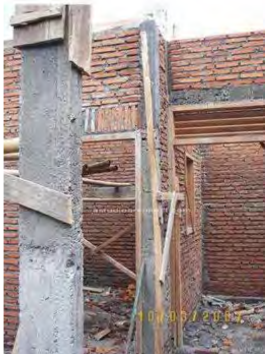
Gambar 5. 20 Pekerjaan kolom yang sudah jadi.
