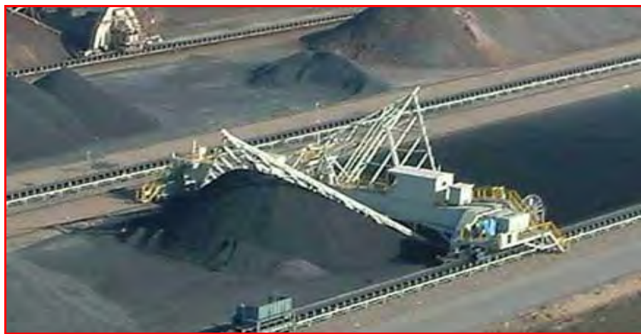
Gambar 7. Penimbunan dengan travelling bridge dengan railway dibawah. ( www.bulk handling.com )
