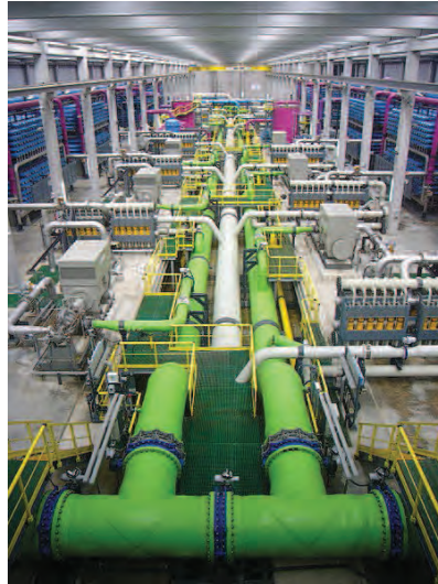
Gambar 9.19 Teknologi Osmosis Balik Skala Industri
